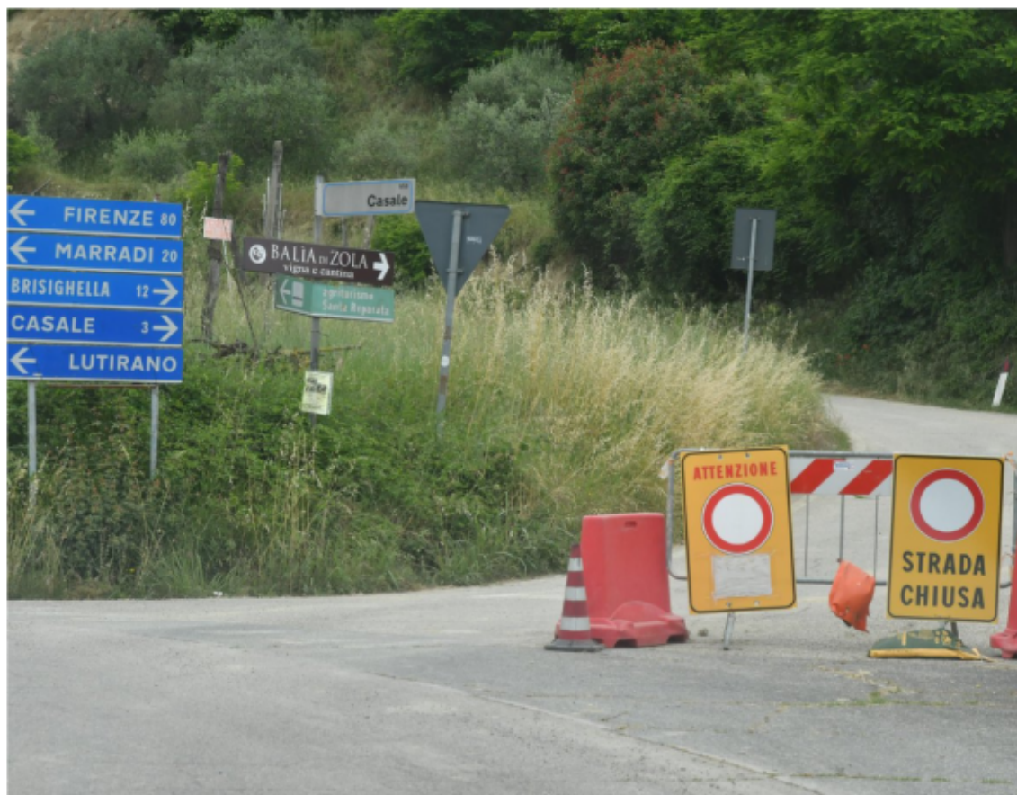
Viabilità interrotta a Modigliana: le strade sono una priorità nell'opera di ricostruzione FOTO BLACO
